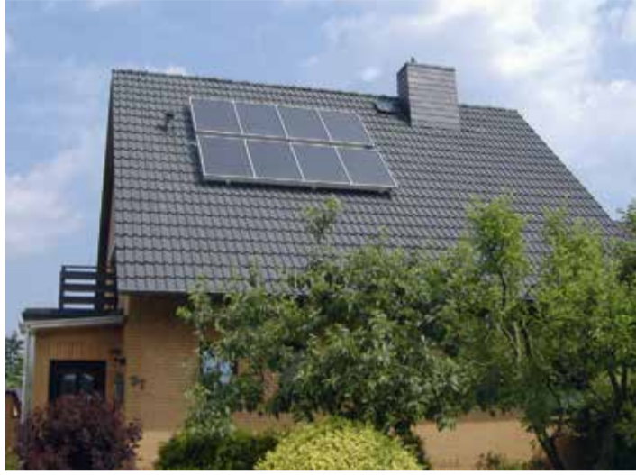
Die Sonnenkollektoren auf dem Dach sind eine umweltfreundliche und kostensenkende Ergänzung des innovativen Heizsystems SolvisMax.
