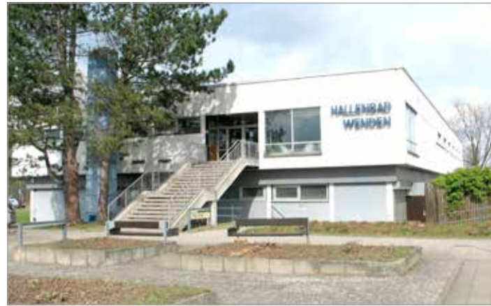
1. Hallenbad Wenden kurz vor dem Abriss
