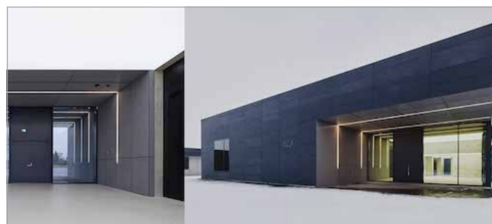
Neubau Aula Lessinggymnasium (2013 bis 2014): 4,71 Mio. €
