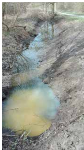
Erdreich ausgekoffert. Der Böschungsbereich wurde neu befestigt.
