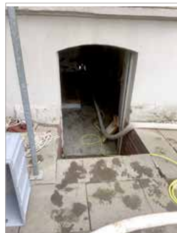
Keller für Keller wurden mit den leistungsstarken Pumpen leergepumpt.
