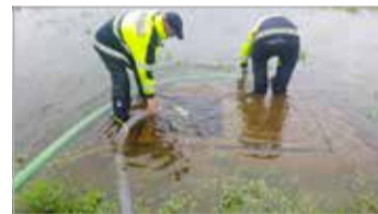
Ein paar Tage vor dem Einsatz in Wolfenbüttel waren die Pumpen am Flughafen im Einsatz, um Schächte trocken zu legen.
