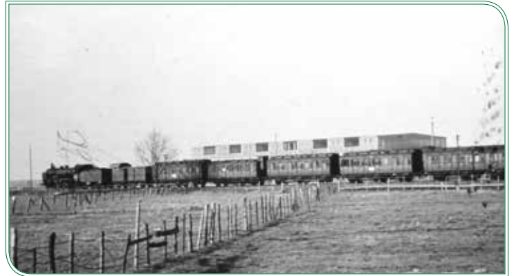
Gleisanschluss Bienrode Lutherwerk 1943
