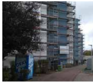
Heute: Fassadensanierung Am Lehmanager (Foto: BauBeCon Sanierungsträger GmbH)
