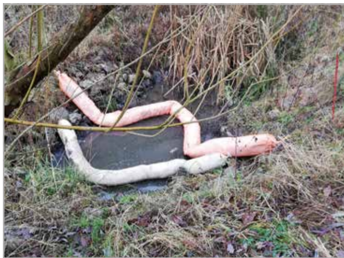
Die Feuerwehr legte zusätzlich Ölsperren aus, die ein weiteres Abfließen der ölhaltigen Flüssigkeit in die Schunter verhindern sollen.
