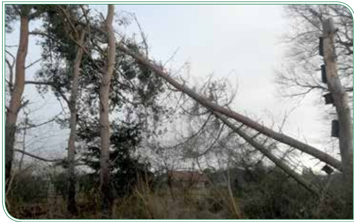
Sturmschaden im Biotop
