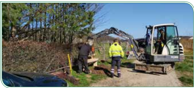
Aufstellarbeiten der Bank
