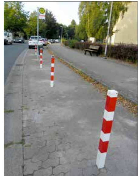
Sperrpfosten an der Haltestelle Neckarstraße
