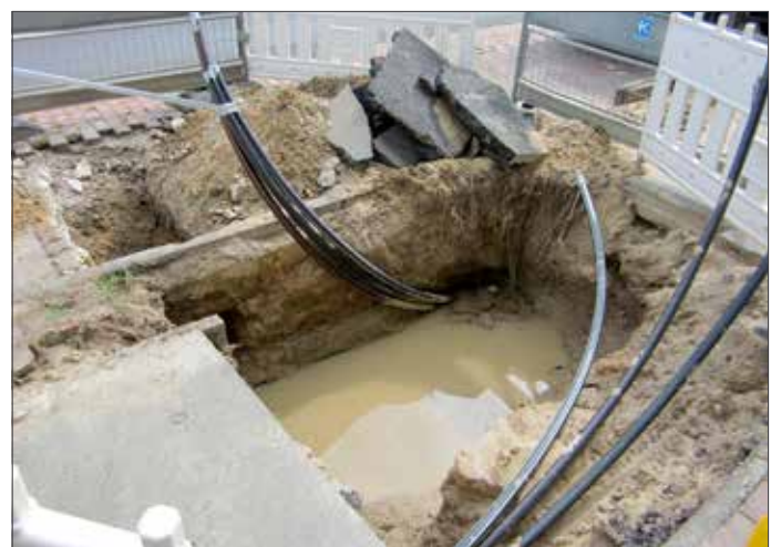
Kabeltrasse an der Donaustraße , 15. Juli 2021
