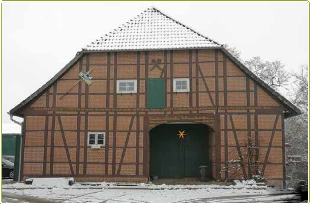
Harxbütteler Fachwerkhaus mit Hausinschrift
