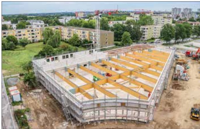
Dachkonstruktion_EKZ_Bauphase
