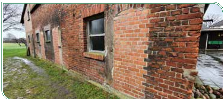
Nach dem Bau des Bienroder Abwassersystems 1962 waren „Plumpsklos“ in den Ställen nicht mehr zeitgemäß. Die Eingänge – wie hier auf dem Hof von Jürgen Cordes – wurden zugemauert.
