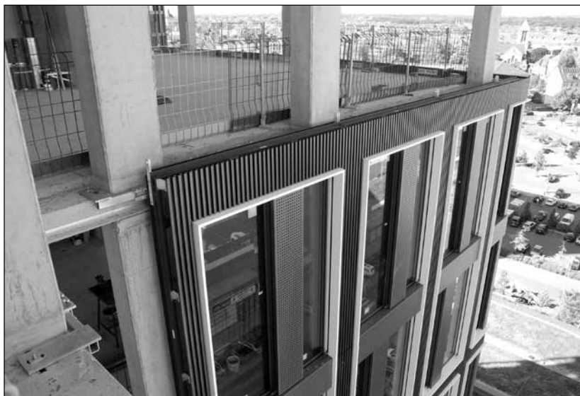
Detailblick: die vorgehängten Fassaden. Alle zwei Wochen kommt ein neues Geschoss dazu
