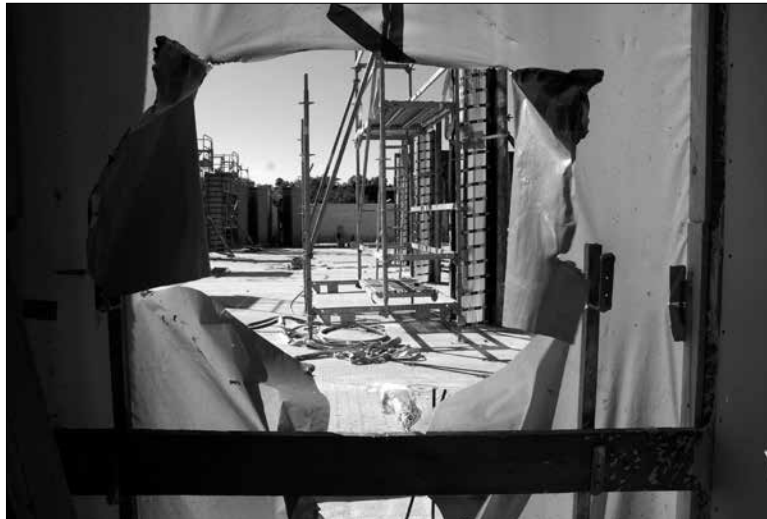
Durchblick auf die wahrscheinlich derzeit höchste Baustelle der Stadt
