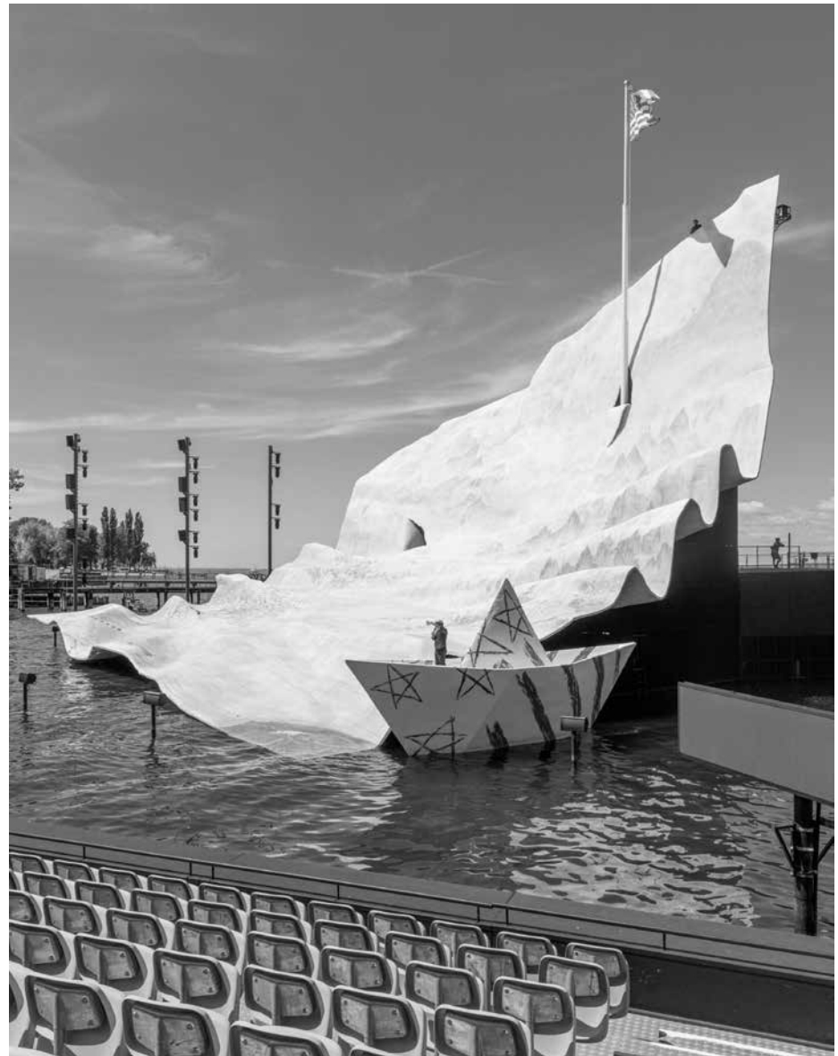
300 Tonnen filigrane Leichtigkeit: Das Bühnenbild für Puccinis „Madame Butterfly“ auf dem Bodensee ist eine robuste Stahl-EPS-Holz-Putz-Konstruktion – und für zwei Spielzeiten der Bregenzer Festspiele ausgelegt.
