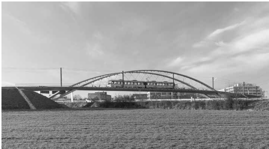
Preisgekrönt: Die Stadtbahnbrücke Stuttgart-Degerloch
