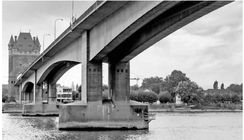
Sagenhaft – und jetzt auch geehrt: Die Nibelungenbrücke in Worms erhält den Titel „Historisches Wahrzeichen der Ingenieurbaukunst in Deutschland“.
