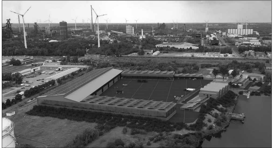
Sanierungsstart in Bremen: Auf dem 13 Hektar großen Areal des ehemaligen Raffinerie-Tanklagers im Ölhafen (oben) wird die STRABAG Umwelttechnik GmbH nach einer umfassenden Bodensanierung ihr erstes Circular Construction & Technology Center (C3) bauen und betreiben Visualisierung Ausbauzustand, Grafik, STRABAG Umwelttechnik GmbH
