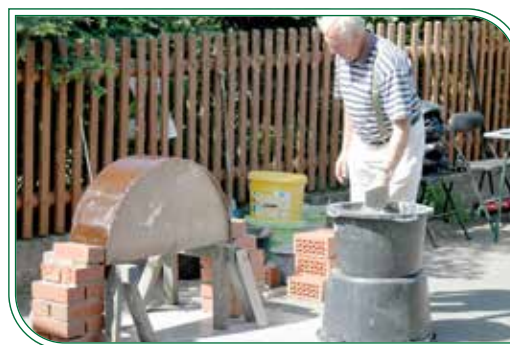
Der Maurer Günter Böhm (2007) mauert einen Torbogen
