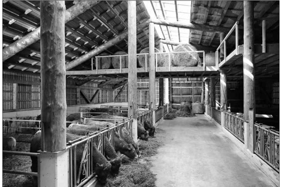
Der preisgekrönte Mutterkuhstall in Clausthal-Zellerfeld: das Tragwerk aus heimischen Rundhölzern im Licht des blendfreien Lichtbands.
