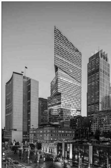
In Form von fünf gestapelten Modulen erhebt sich der Quay Quarter Tower unweit des Circular Quay und dem Botanischen Garten im zentralen Geschäftsviertel Sydneys.
