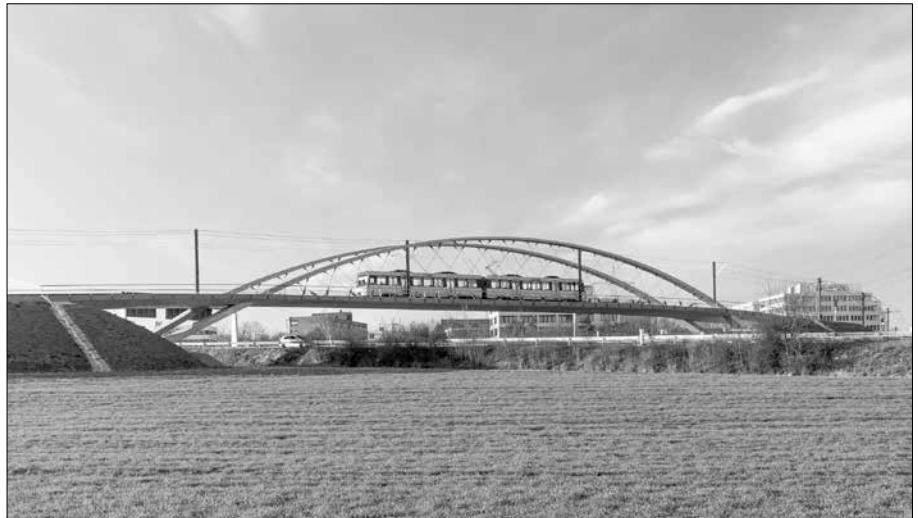
Noch ein Gewinner: Die Stadtbahnbrücke Stuttgart
