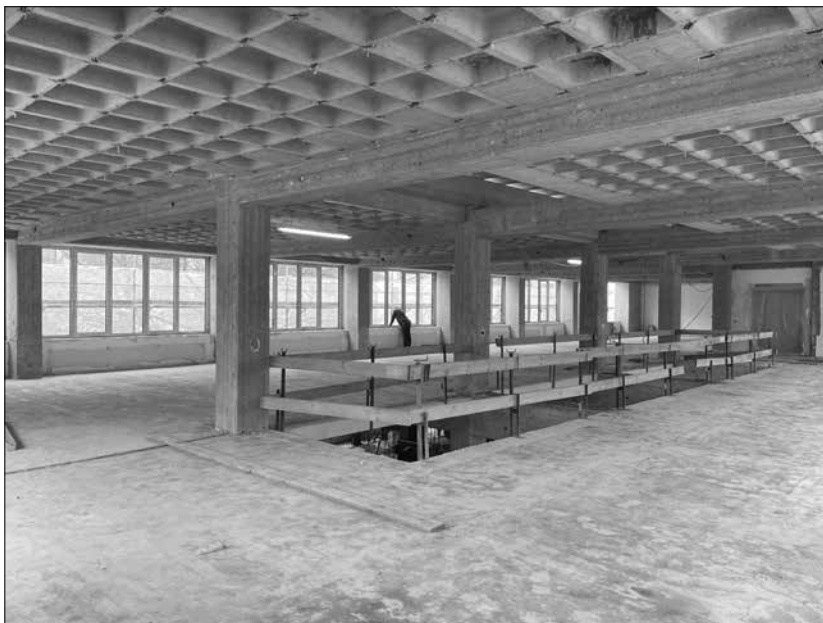
Mit der Nutzung der vorhandenen Rohbaubsubstanz wurden rund 305 t CO 2 eingespart
