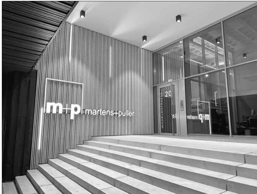
Die neue Hauptniederlassung von m+p zeigt, wie man einer Bestandsimmobilie nicht nur ein zweites, sondern auch ein ganz neues Leben einhauchen kann
