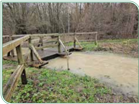
Beberbach voll und Brücke
