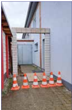
Ganganbau auf der Ostseite
