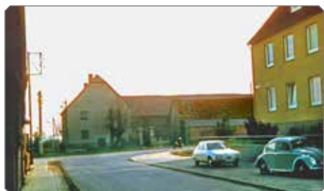
Broitzemer erhalten Straßenbahnanschluss, Wendeschleife auf Grundstück des früheren Hofes Meyerhoff, 1973
