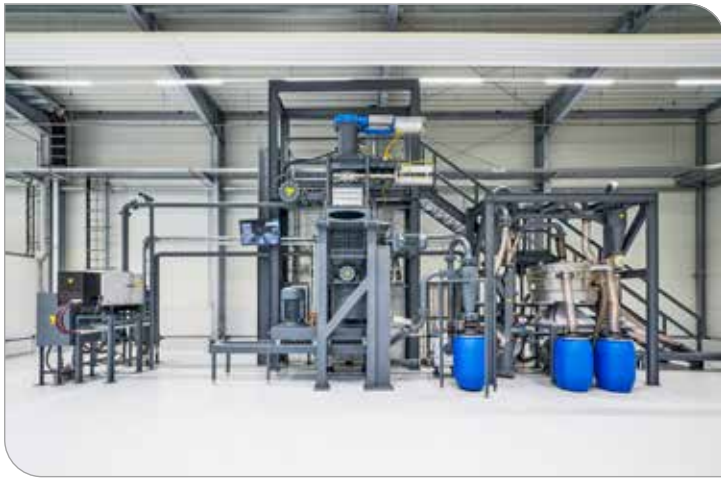
Pilotanlage zum mechanischen Recycling von Lithium-Ionen-Batterien Foto: Wölfiam Schroll/No Canary GmbH
