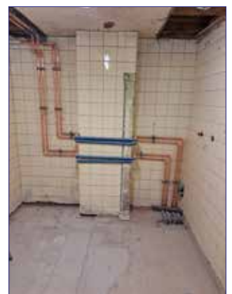
Mittelbereich vor dem Einbau der neuen Abwasserleitung sowie Einbau der Heizungsleitungen
