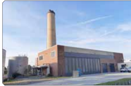
Das Heizkraftwerk Mitte an der Hamburger Straße wird von den Stadtwerken betrieben. Weithin
