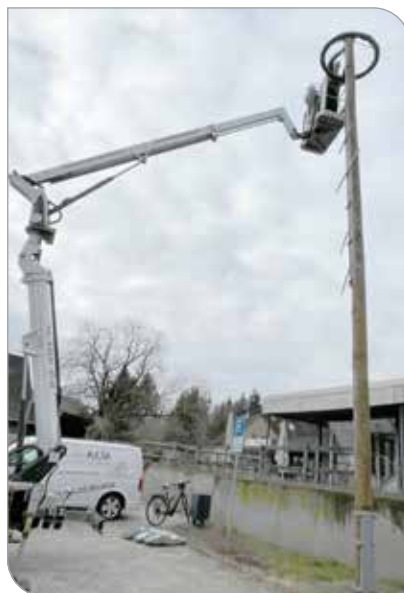
Stefan Maving und Ingo Knigge beim Abbau des Kranzes
