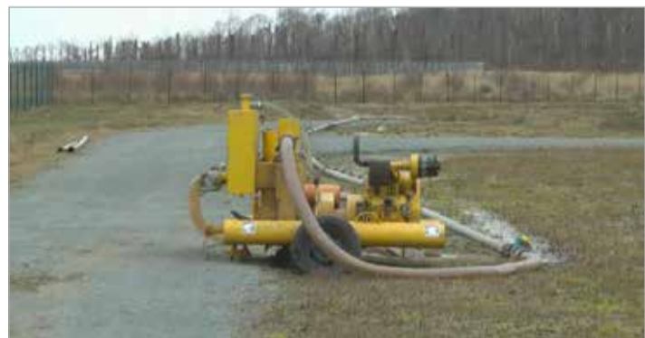
Standort 1 Dieselbetriebene Pumpe am Pflanzenklärbecken
