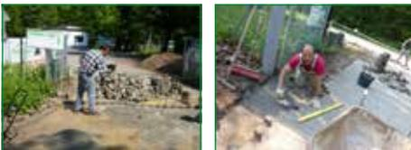
Einfahrt: Aufbringen neuen Splitts sowie Neuverlegung der Pflastersteine durch die Firma M. Iclek (Mascherode)
