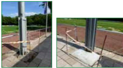
A-Platz: Flutlichtmast (Westseite), vor Ausbesserung des Fundaments [links], nach Ausbesserung [rechts]
