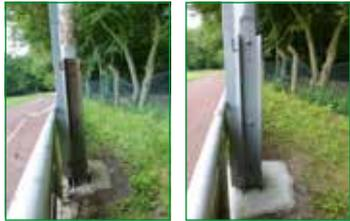
A-Platz: maroder Flutlichtmast (Ostseite) [links]; Flutlichtmast nach Sanierung [rechts]
