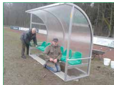
Bernt Ritter und Horst Rose beim Anziehen der letzten Schrauben für die Betonverankerung der neuen Kabinen. Foto: Siegmund Lang
