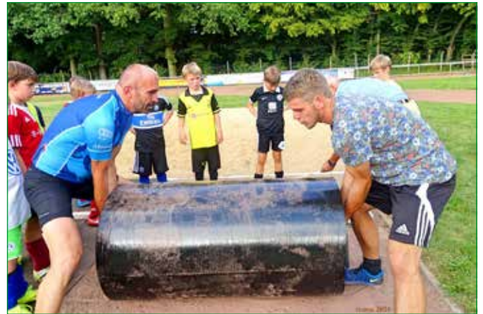
Christoph Siemers (links), Tobias Pulkenat und Fußballkinder beim Verlegen der 30 m Regupol-Anlaufbahn
