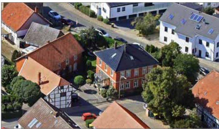
Steinbrink 8, ehemalige Schmiede Kalberlah, saniert 1996
